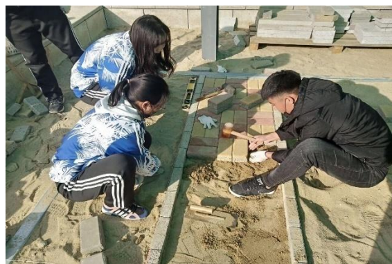
图 2-14 园林系学生进行透水砖铺装训练
